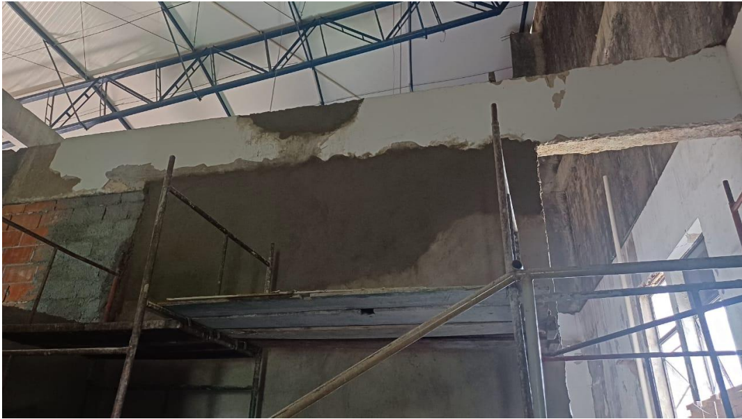
Reboco na alvenaria de circulação
