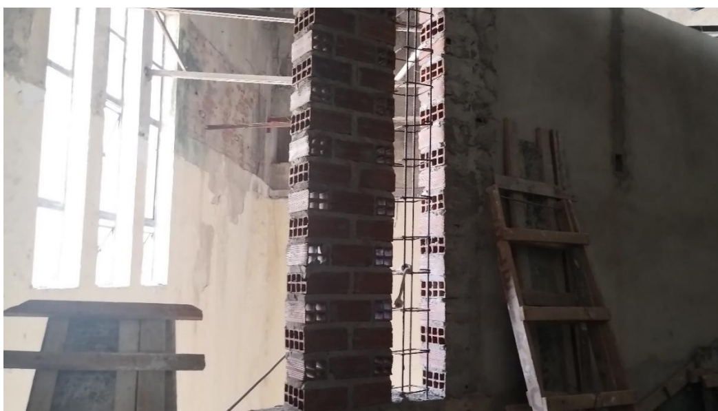
Construção de alvenaria – Lado Paraguai
