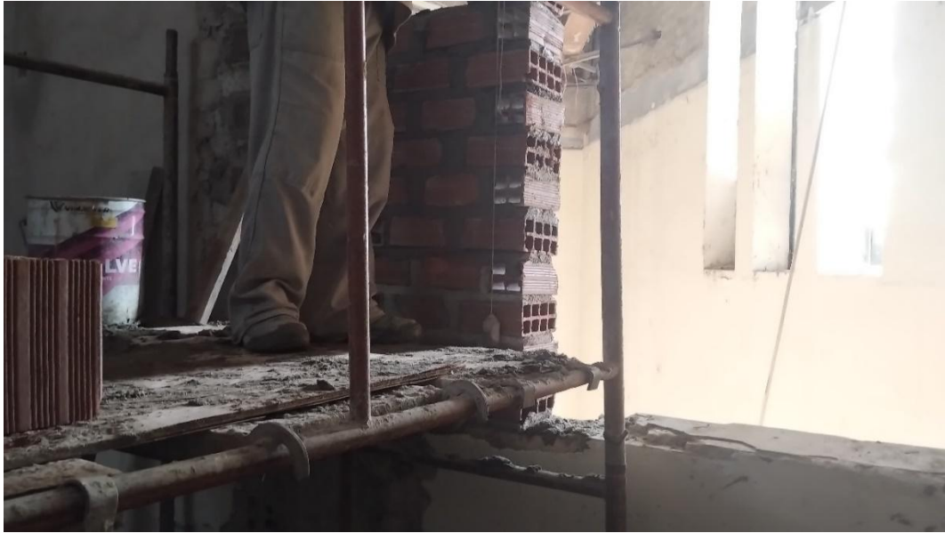
Construção de alvenaria – Lado Paraguai
