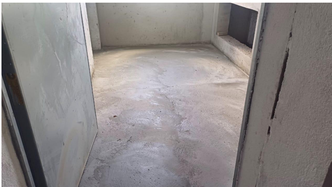
Piso de argamassa na antecâmara – Lado Paraguai
