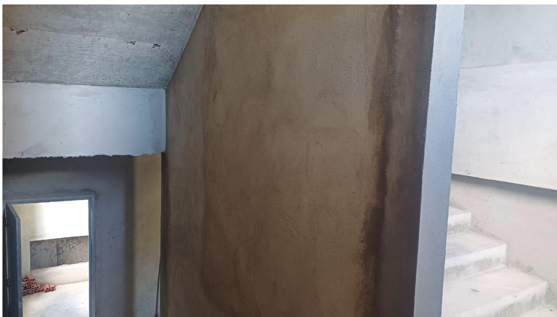
Acabamentos na área da escada – Lado Brasil
