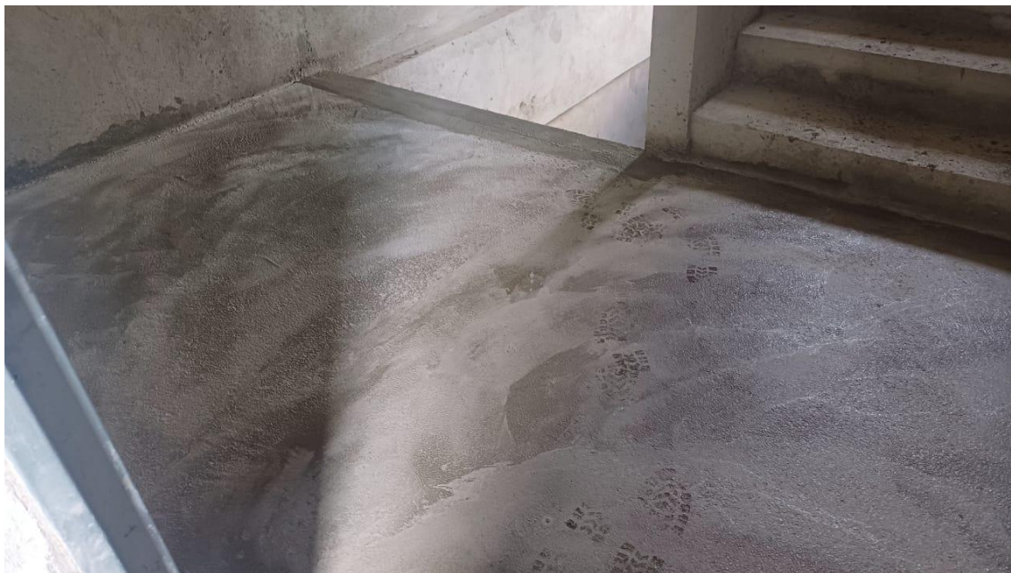
Piso de argamassa no patamar – Lado Paraguai
