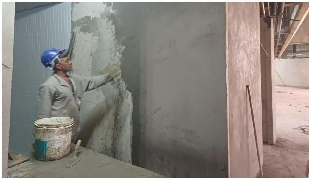
Aplicação do reboco no PNE feminino
