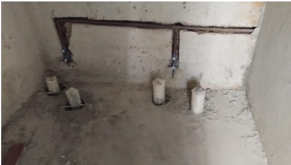
Contrapiso do WC masculino
