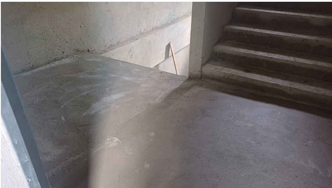
Piso de argamassa no patamar – Lado Paraguai
