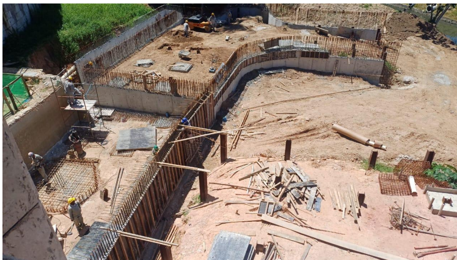
Concretagem da cortina
