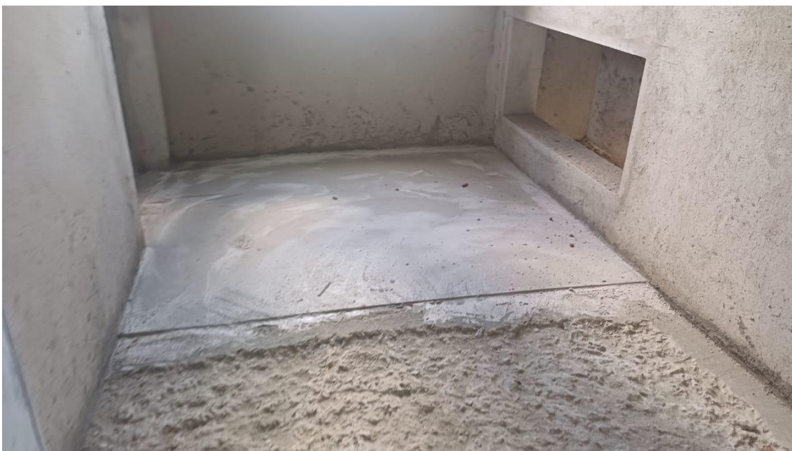
Piso de argamassa na antecâmara – Lado Paraguai
