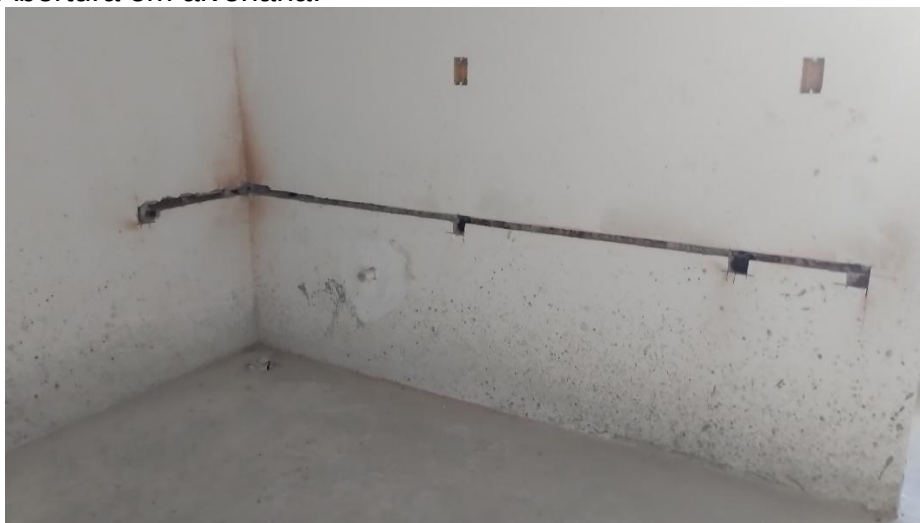
Abertura de alvenaria no camarim VIP 1
