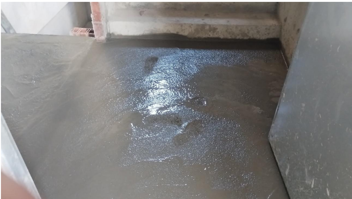
Piso de argamassa no patamar – Lado Paraguai
