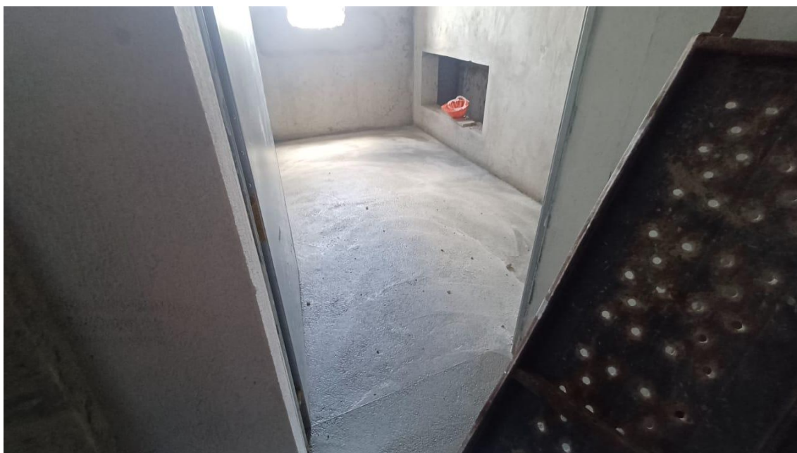
Piso de argamassa na antecâmara – Lado Paraguai
