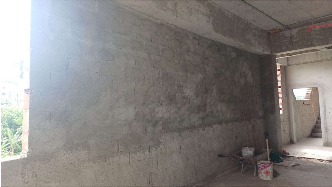
Alvenaria de vedação – Lado Brasil
