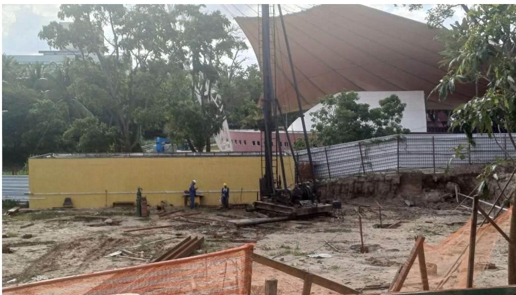
Cravação de estacas
