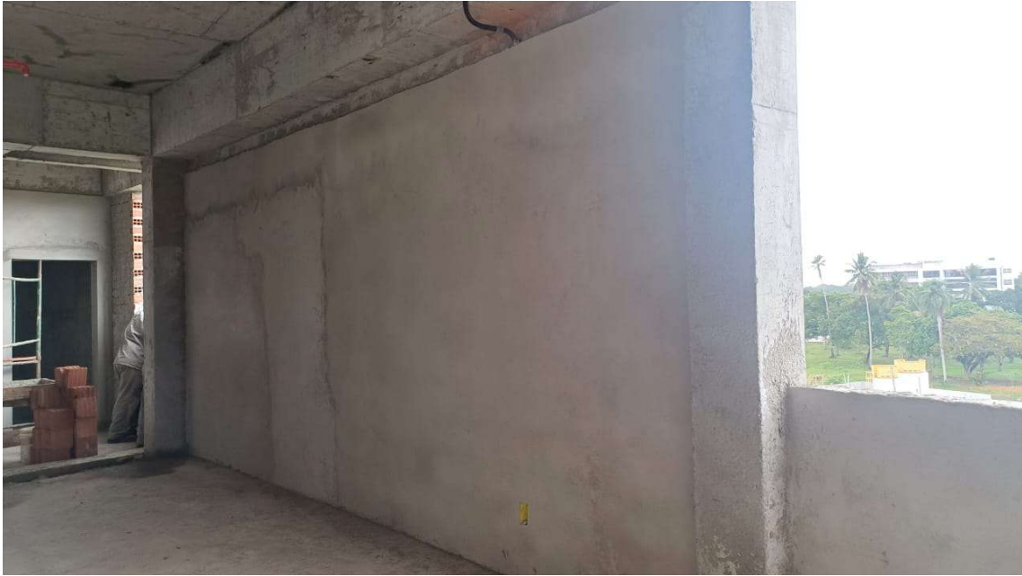
Alvenaria de vedação – Lado Paraguai
