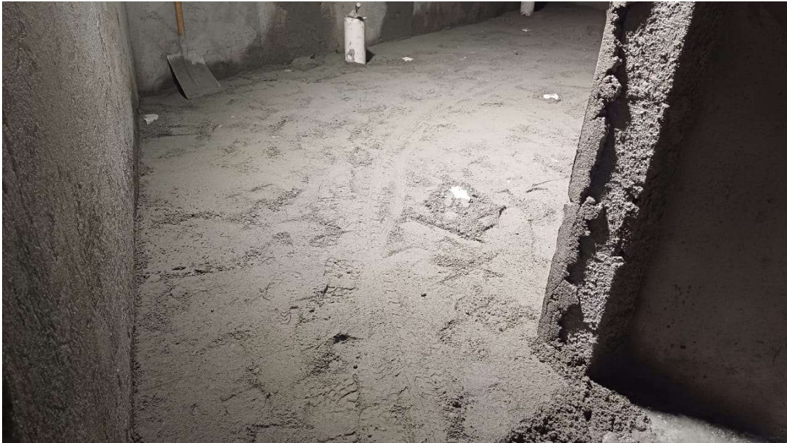
Contrapiso no WC feminino
