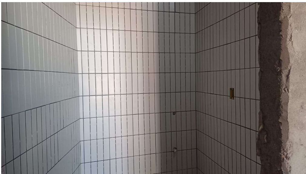
Revestimento no DML
