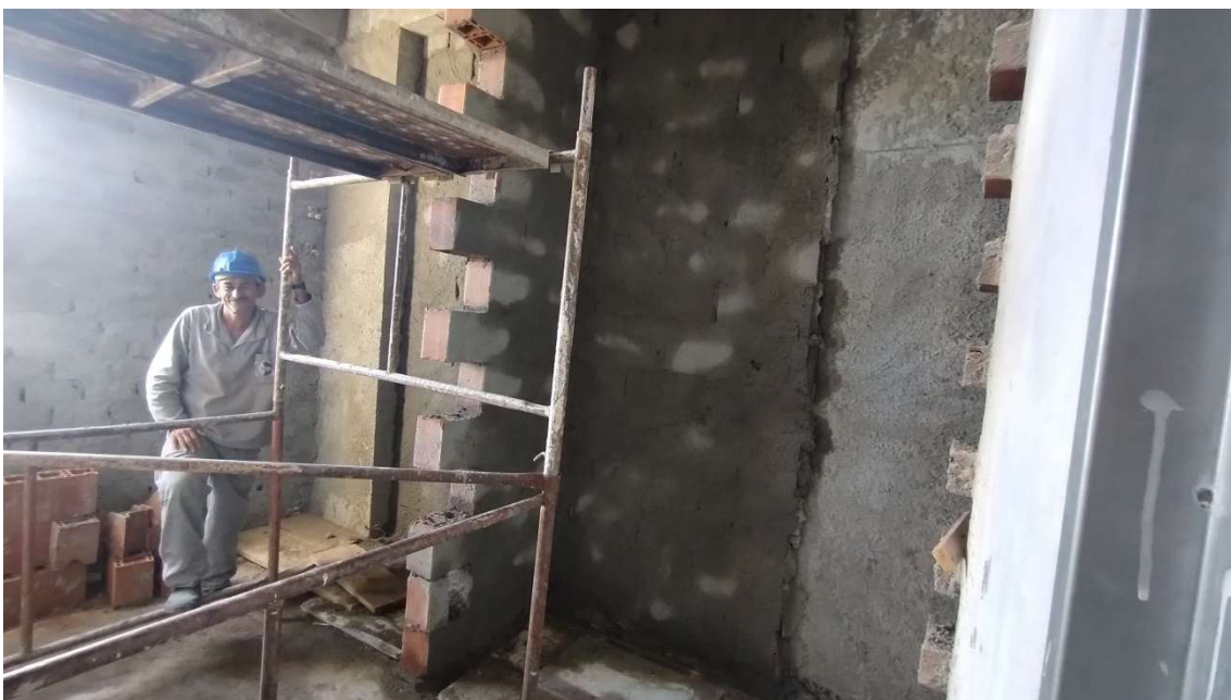
Construção da alvenaria da antecâmara – Lado Paraguai
