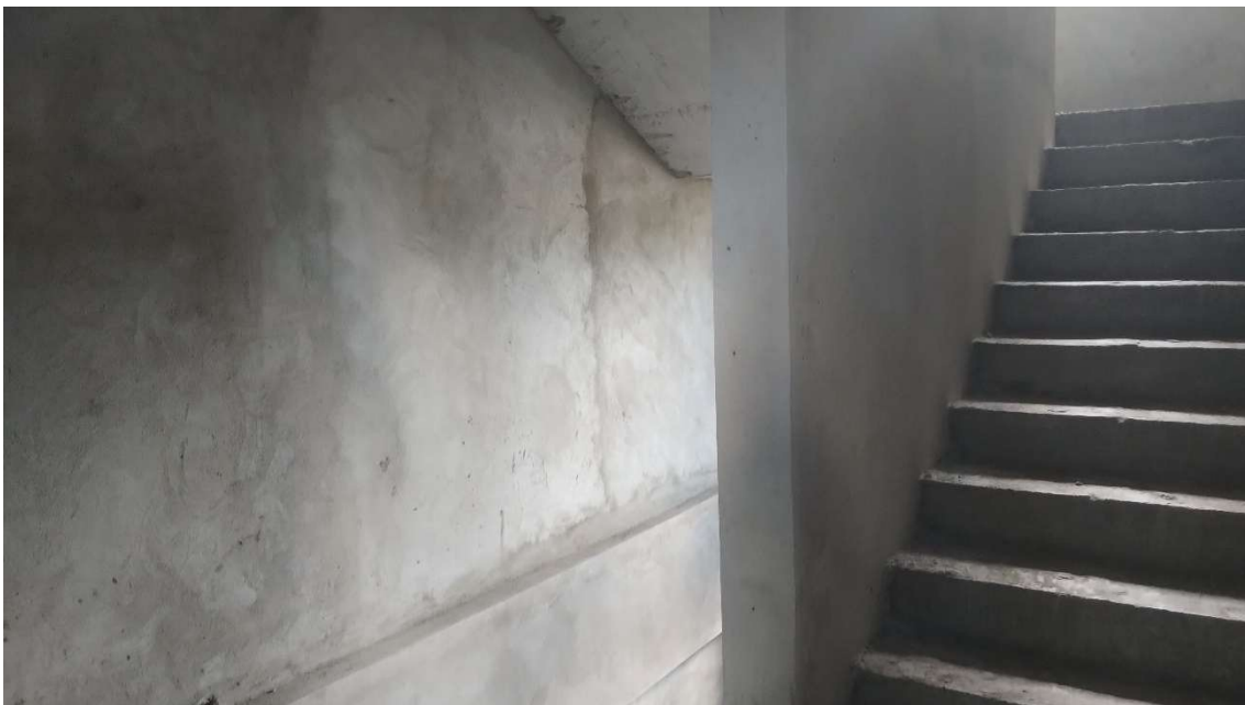
Camada de reboco na escada – Lado Brasil
