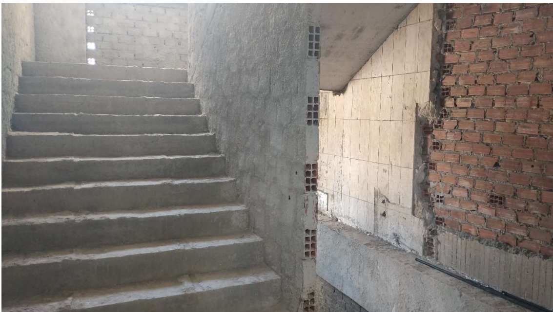
Camada de chapisco na escada – Lado Brasil
