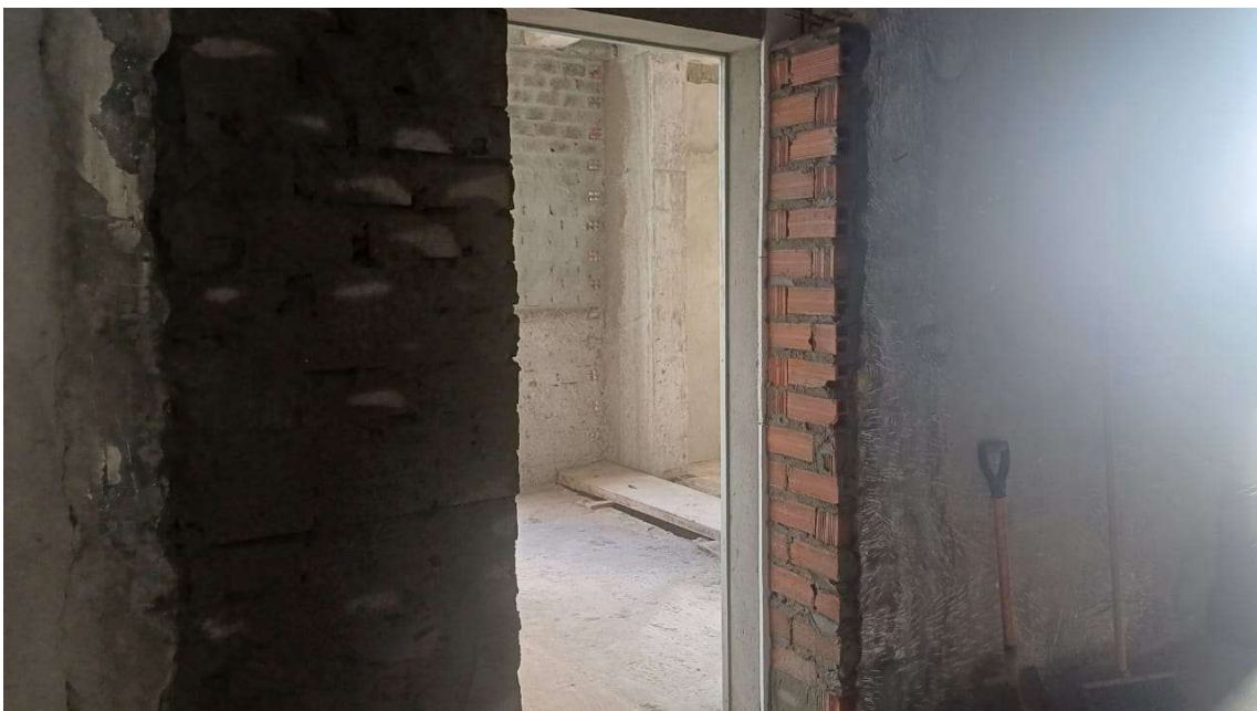
Camada de chapisco na alvenaria da antecâmara
