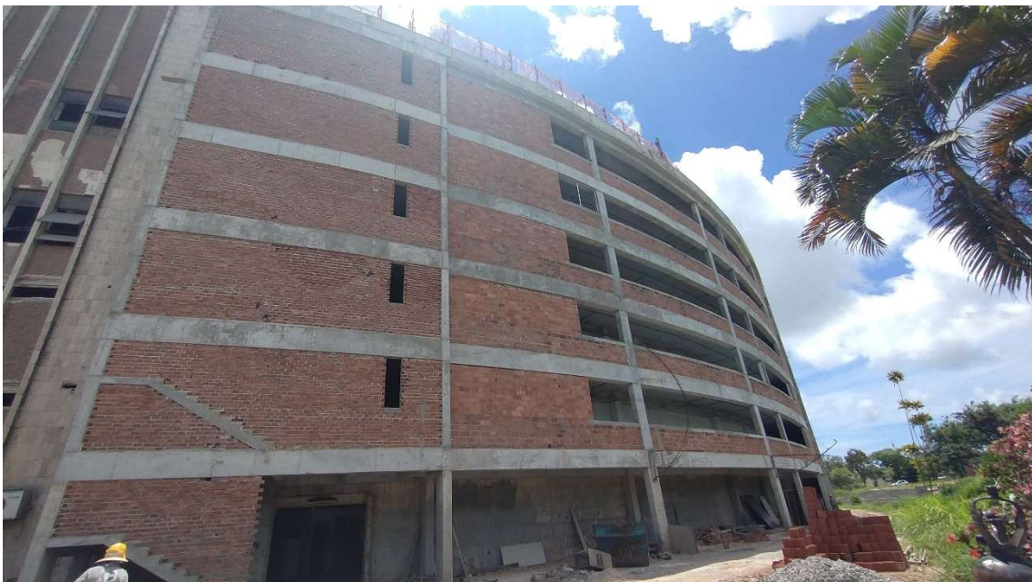
Vista externa da escada e circulação
