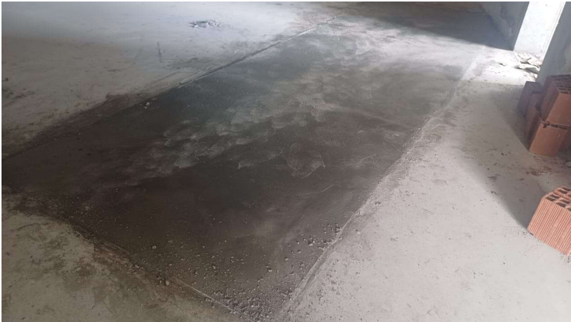
Piso de argamassa na Coxia
