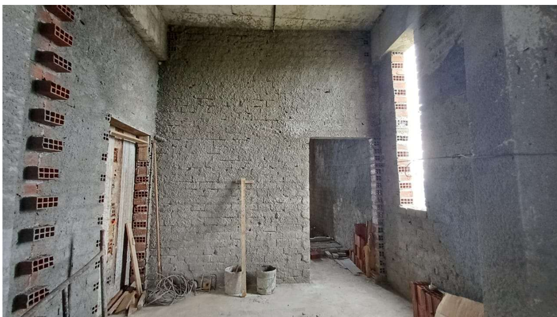
Camada de chapisco na antecâmara – Lado Paraguai
