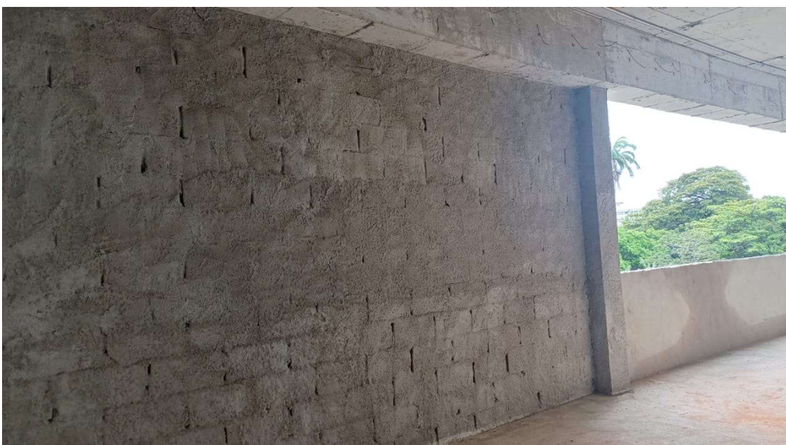
Alvenaria de vedação – Lado Paraguai
