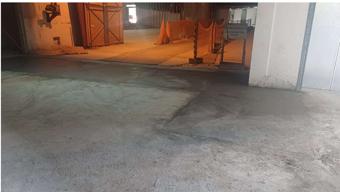
Piso de argamassa na Cobia
