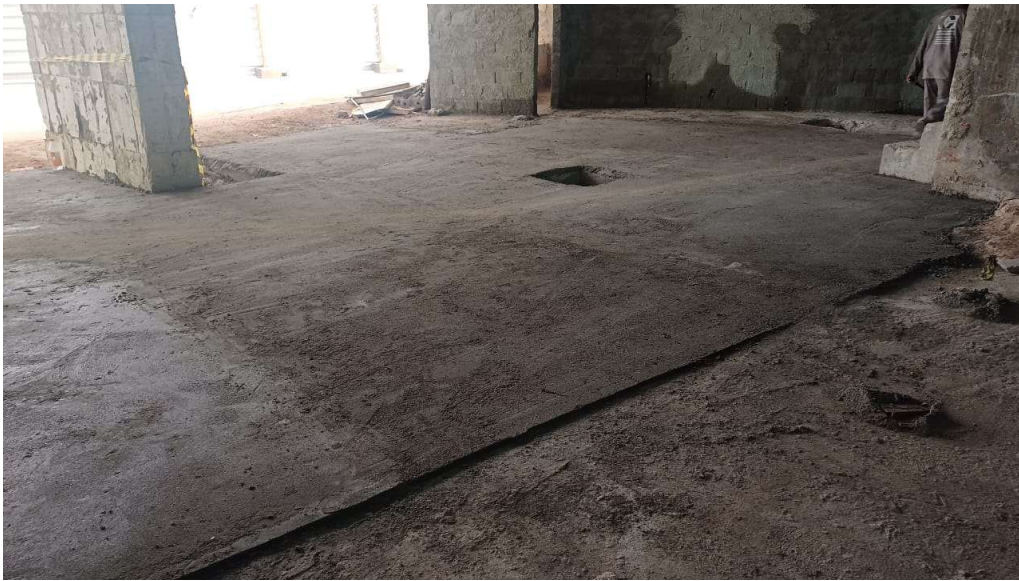
Construção do contrapiso
