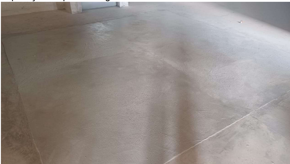
Piso de argamassa na Hall
