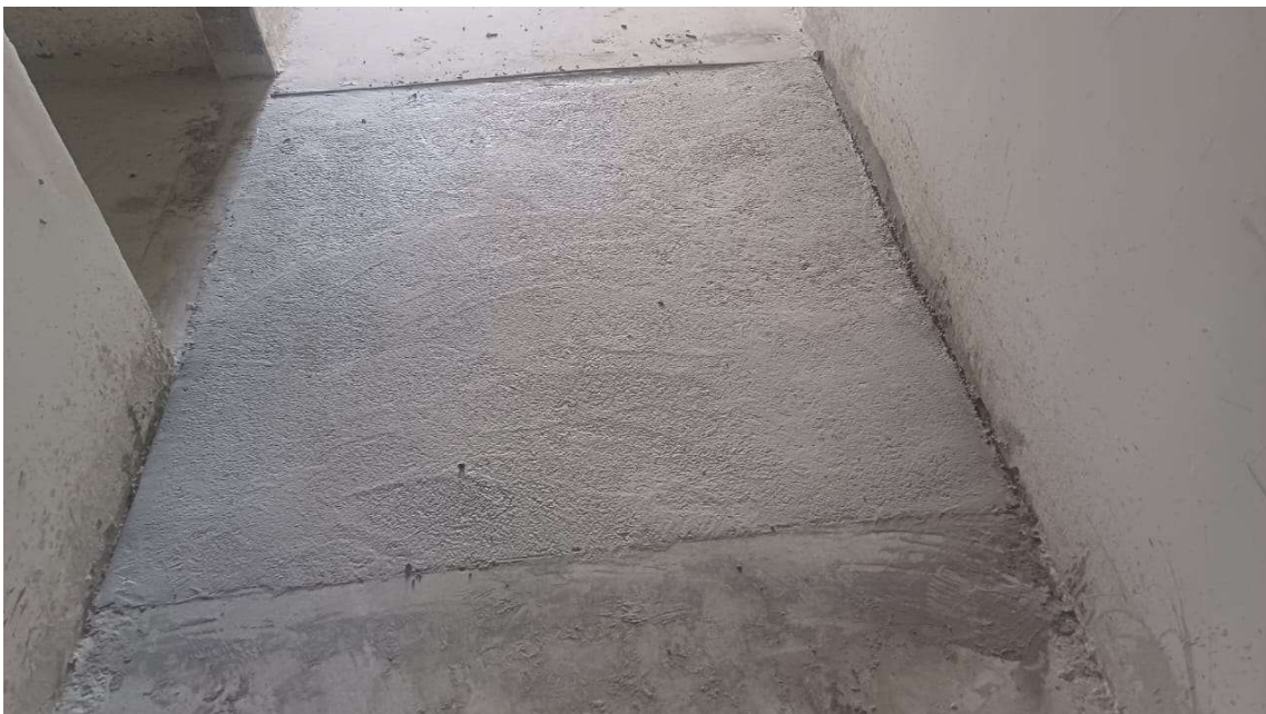
Piso de argamassa na circulação
