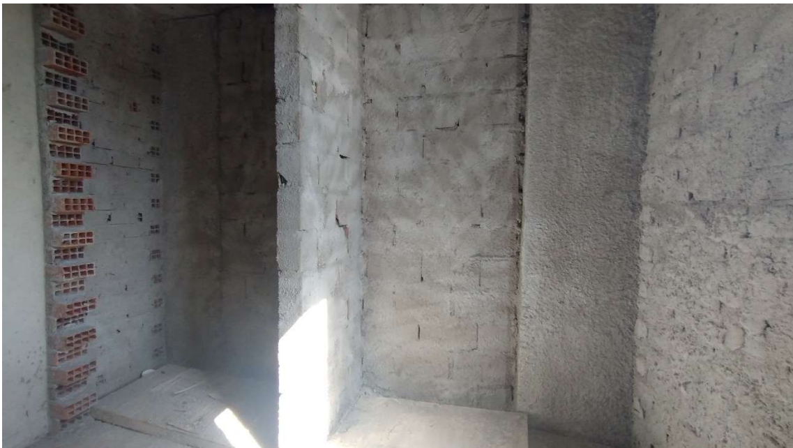
Alvenaria da antecâmara – Lado Paraguai
