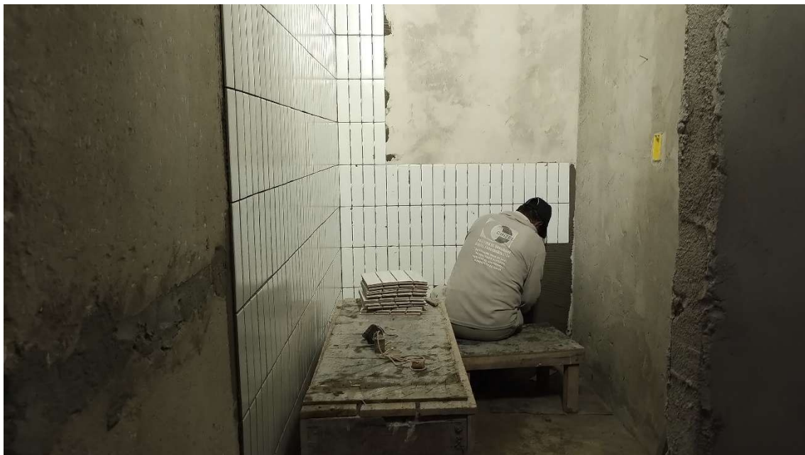
Revestimento do PNE masculino
