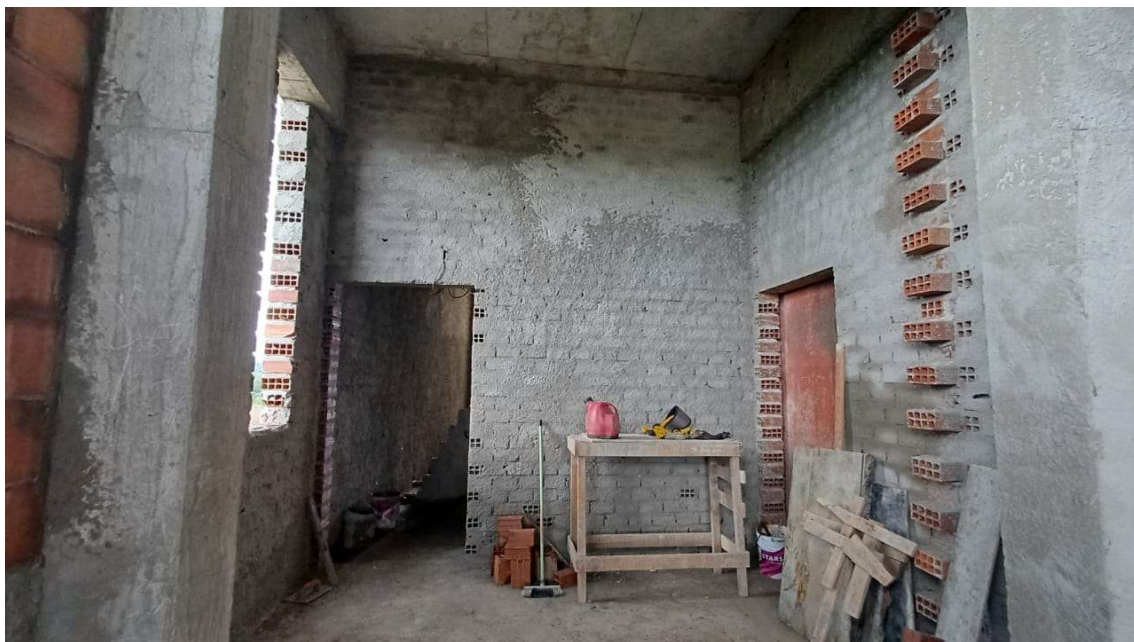
Camada de chapisco na antecâmara – Lado Brasil
