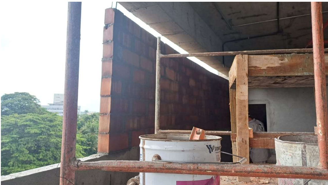
Alvenaria de vedação – Lado Brasil
