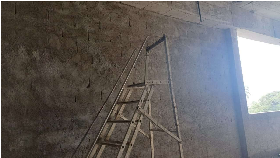
Alvenaria de vedação – Lado Paraguai
