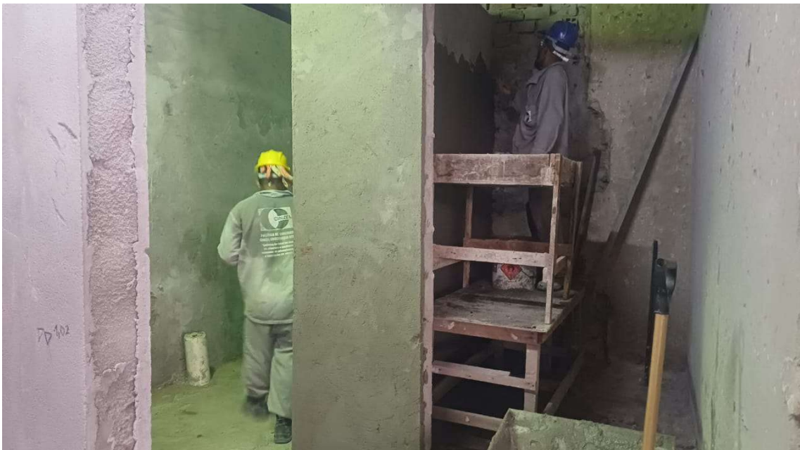
Camada e reboco no PNE feminino e fraldário
