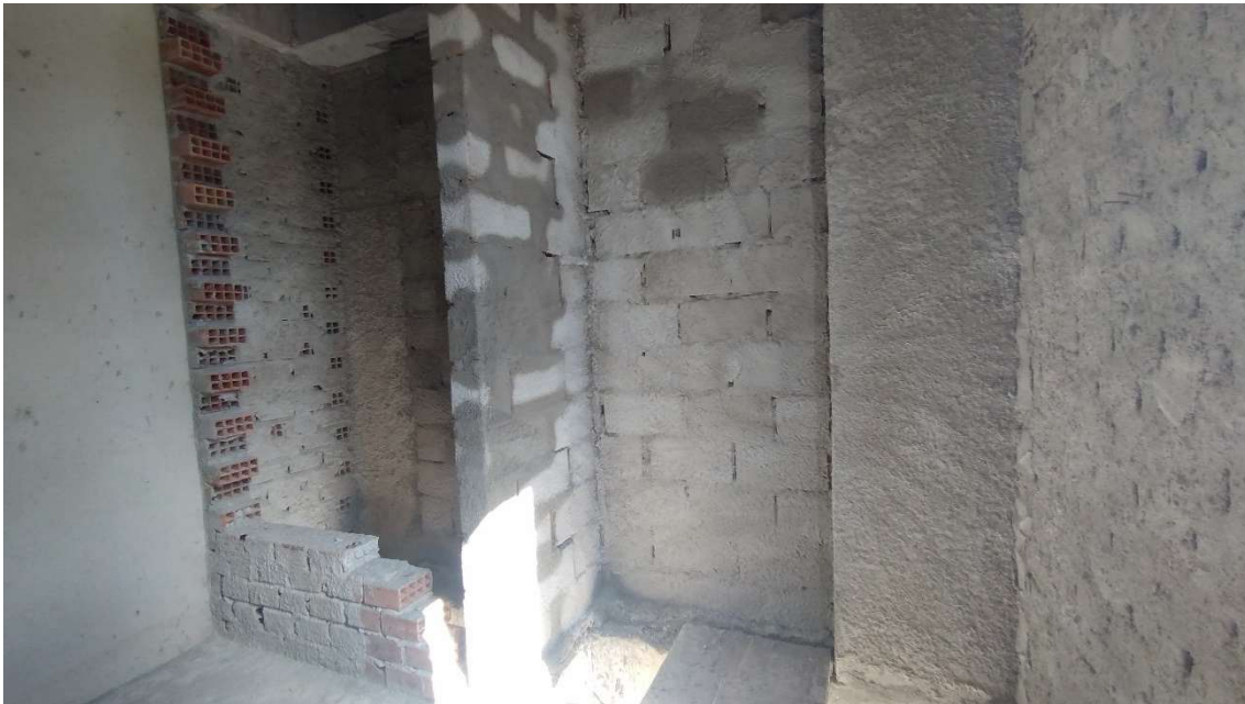
Construção da alvenaria da antecâmara – Lado Brasil
