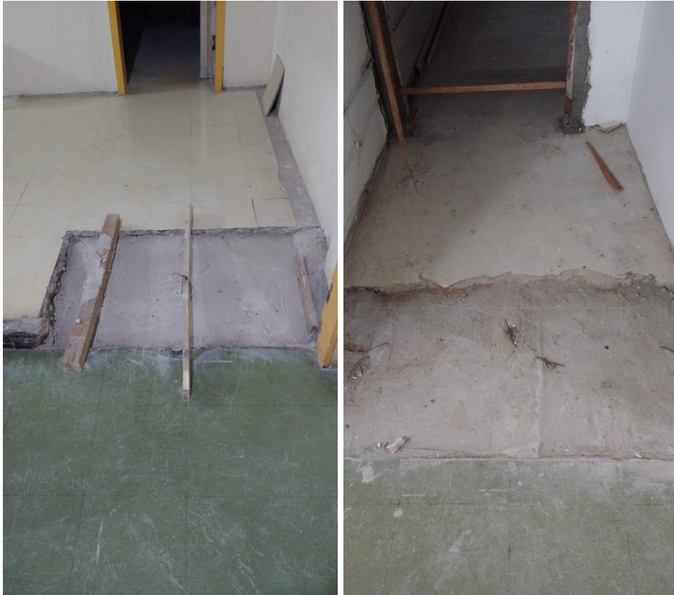
Figuras 1 e 2 – Rampa de acesso às salas.
