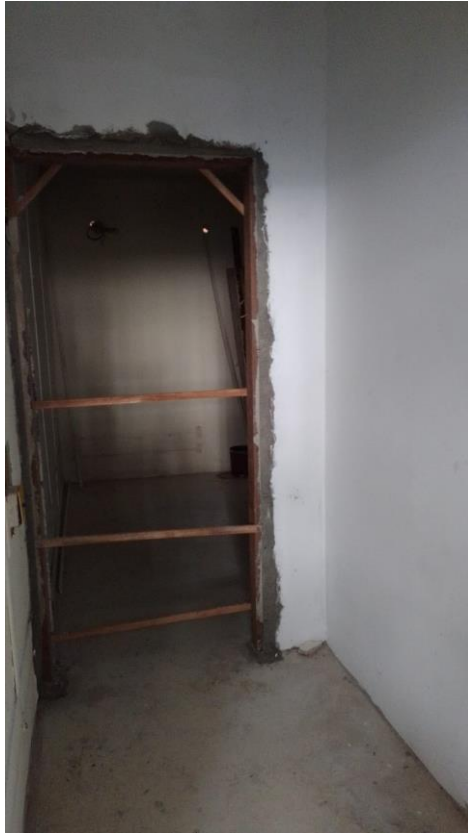
Figura 7 – Assentamento da grade de porta.
