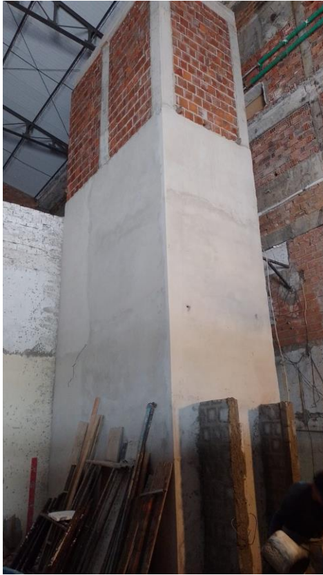
Figuras 3 e 4 – Caixa do Elevador. Finalização alvenaria e reboco.
