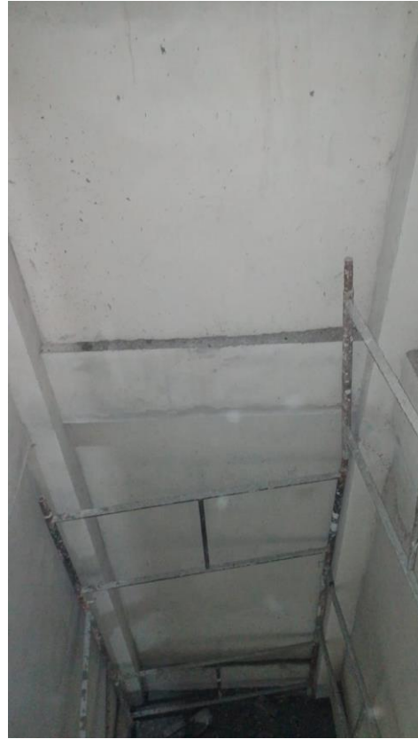
Figuras 3 e 4 – Caixa do Elevador. Finalização alvenaria e reboco.
