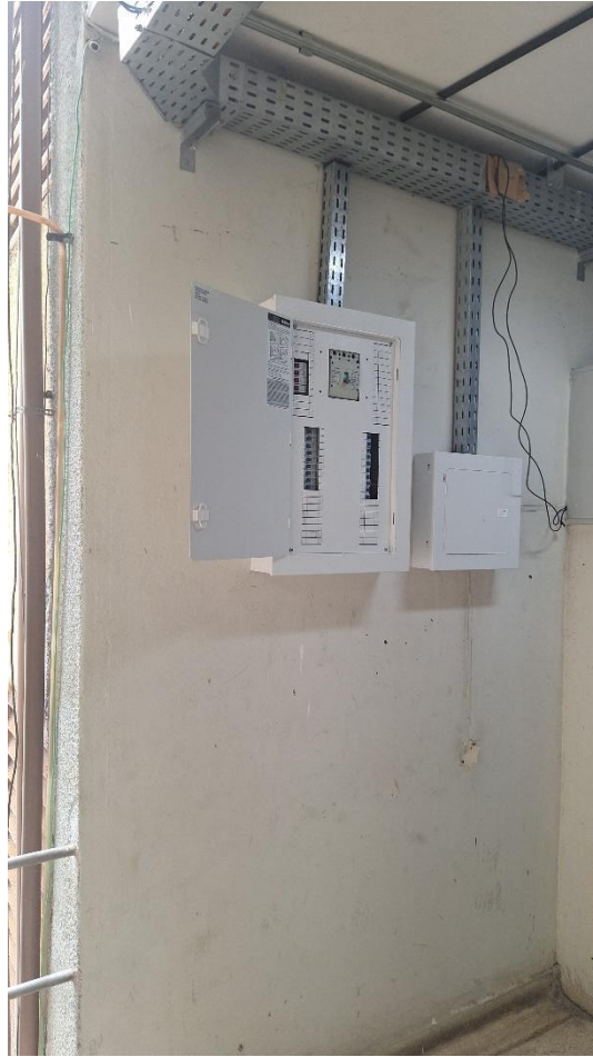
Instalação do QDC - 2 andar
