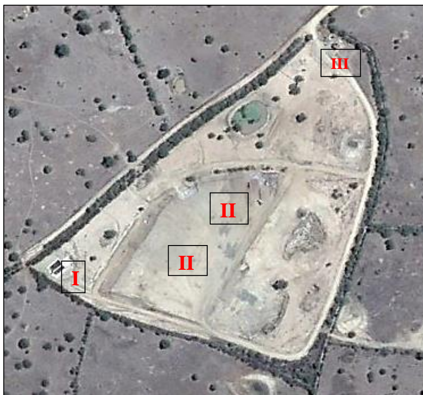
Figura 19: aterro sanitário de Altinho - Sítio Juá - Zona Rural de Altinho; 8°28'27.69"S; 36°00'26.67"O. (I) estação de tratamento de efluentes; (II) células de deposição dos RSU; (III) setor administrativo e balança.
