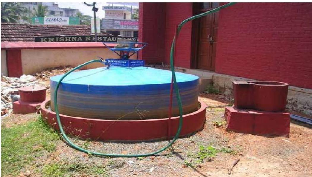
**Figura 6. Biodigestor Utilizado em Residência na Índia. Fonte: Vögeli & Zurbrügg, 2008.**
