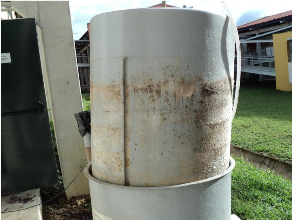
**Figura 23. Cilindro superior deslocado devido ao acúmulo de biogás no biodigestor**
