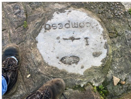
Figura 35: Caixa Lacrada com cimento
