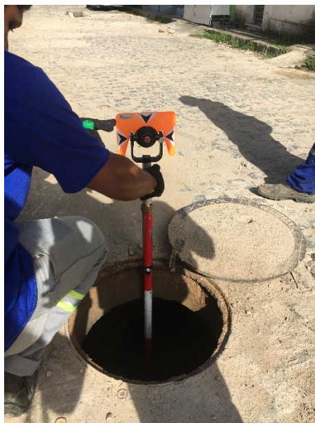
Figura 33: Coleta da Profundidade do Poço de Visita
